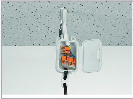
Anschluss von Pendelleuchten in abgehängten Decken
